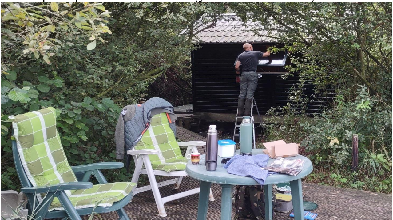
Onderhoudswerkzaamheden aan de blokhut, Venebuurt 14 september 2022
